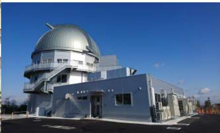
東アジア地域最大となる口径3.8m望遠鏡が今年2月から観測を開始しました。世界最軽量で高速駆動が可能な構造に世界で2例目で国内初の分割鏡による主鏡を搭載するなど、多くの自主開発技術が盛り込まれたユニークな望遠鏡です。
